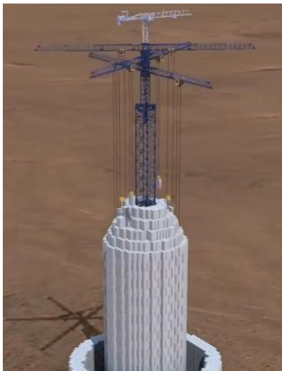
混凝土块积木式重力储能
